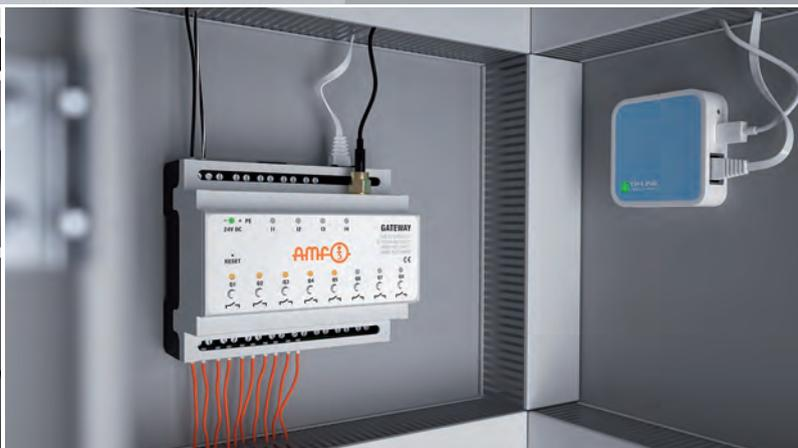
**4** Für eine leichtere Inbetriebnahme kann optional ein WLAN-Router angeschlossen werden, um mittels Tablet auf die webbasierte Benutzeroberfläche des Gateways zuzugreifen.
